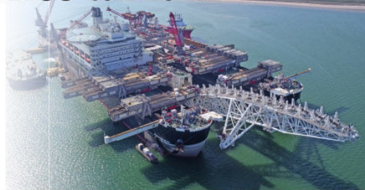
TürkAkım Projesi'nde derin deniz kısmındaki boru hattı inşası, 382 metrelik uzunluğa ve 124 metre genişliğe sahip dünyanın en büyük inşaat gemisi Pioneering Spirit tarafından yürütülüyor.
